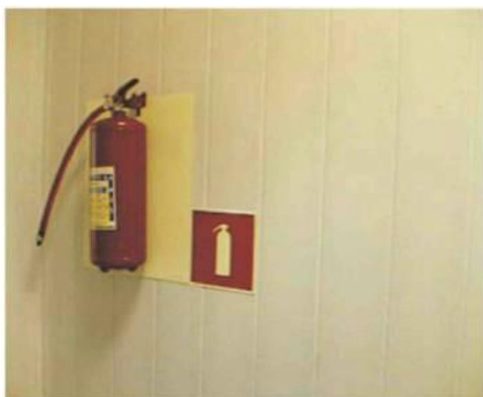
Рисунок А.6 - Обозначение фотолюминесцентной 50-мм лентой контура пожарного оборудования и использование знаков пожарной безопасности
